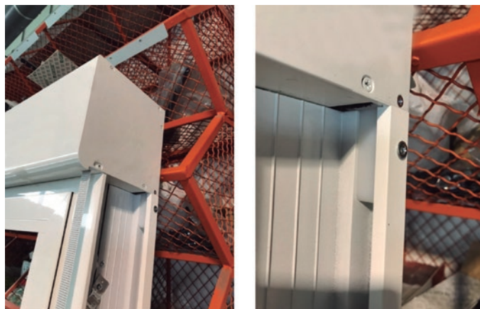
Figura 61. Embudo introducido en guía, con atornillado lateral
