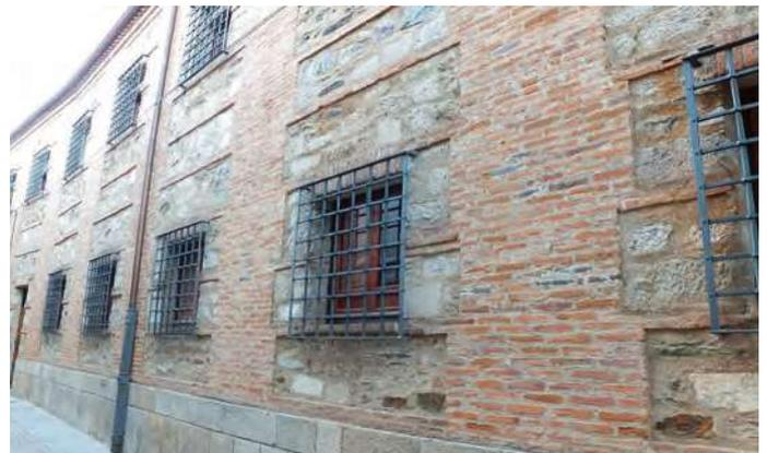
Figura 1: fachada de fábrica con mampuestos de ladrillo y piedra.
