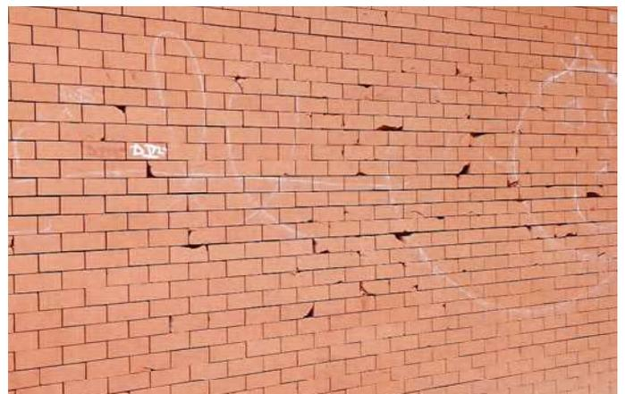
Figura 2: fábrica con junta oculta y existencia de desportillados.
