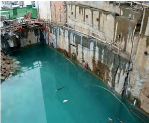
Figura 3: pantalla de hormigón. Efecto del agua.
