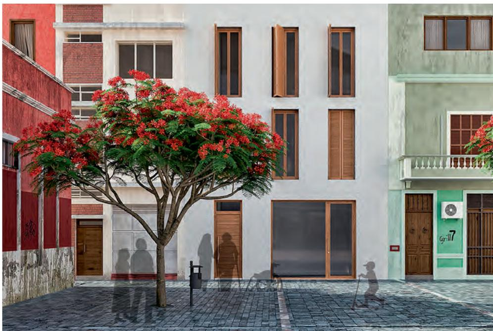
**A**irlab es un edificio diseñado con criterios de bioconstrucción, bajo los dictados Passivhaus, que apuesta por la construcción industrializada en seco y, sobre todo, por la accesibilidad desapercibida, incorporando I+D, con el objetivo de que pueda ser replicable. Se trata de un inmueble de vivienda vacacional, de 39,40 m<sup>2</sup> construidos por planta, con un pequeño local comercial en planta baja, y una vivienda accesible en planta primera, segunda
