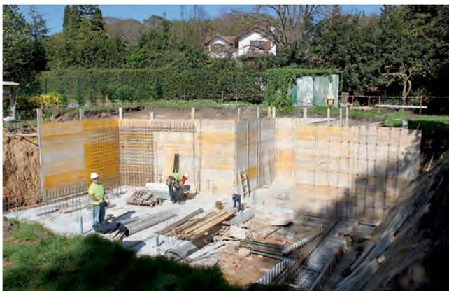
La planta baja que apoya en el terreno se cimenta mediante una losa de hormigón armado de 30 cm. El techo del sótano queda dentro de la envolvente térmica; aun así, se aísla con 10 cm de XPS para mantener los niveles en toda la planta baja.
