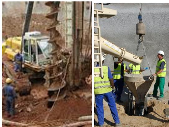
Figura 1-2: Ejecución de pilotes
