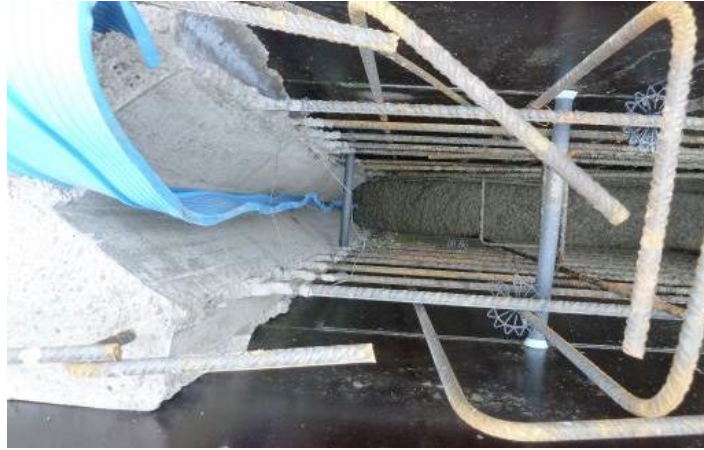
Figura 12. Junta de hormigonado y retracción
