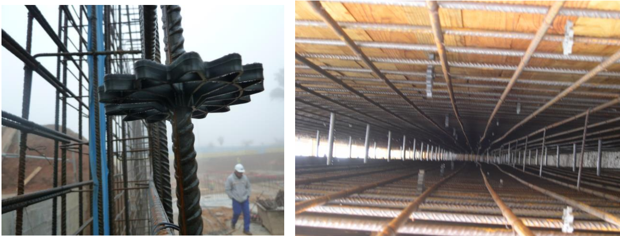
Figura 11. Colocación separadores en el armado del muro
