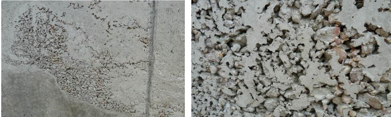
Figura 5. Nidos de grava en muros
