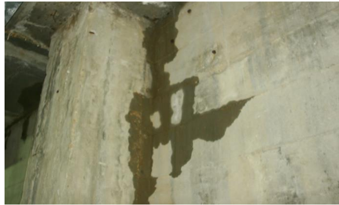
Figura 4. Muro de sótano. Filtración
