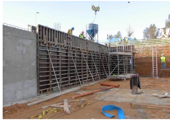
Fig. 1: Ejecución muro contención
