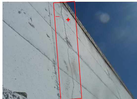
Figura 8. Fisura por flexión parcial en muro
