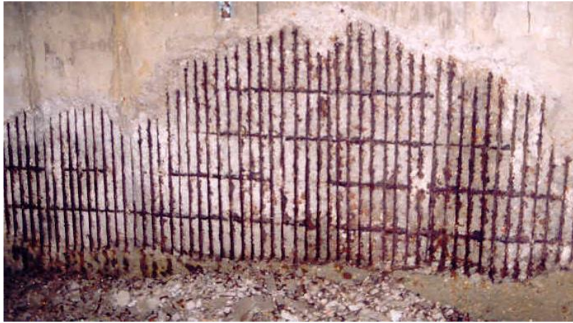
Figura 7. Desprendimiento por corrosión de armaduras
