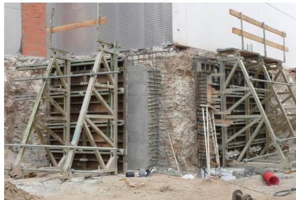
Fig. 2: Ejecución muro por bataches
