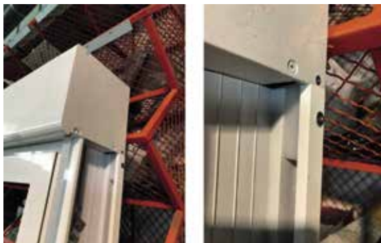
Figura 60. Embudo introducido en guía, con atornillado lateral
